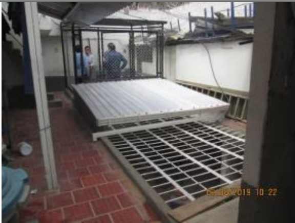
Adecuación civil e instalación de nueva planta eléctrica de 15 kVA EPAMS CAS COMBITA
