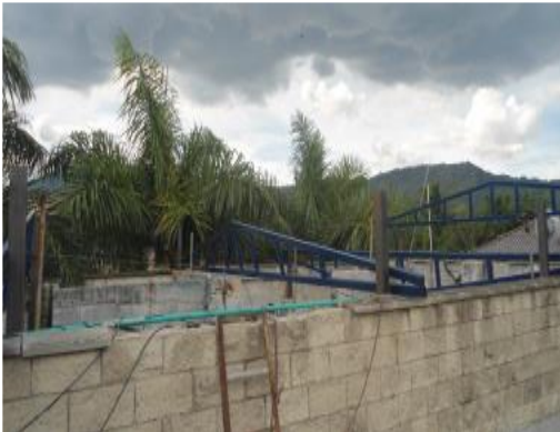
Instalación de estructura para cubierta, sobre dirección.
