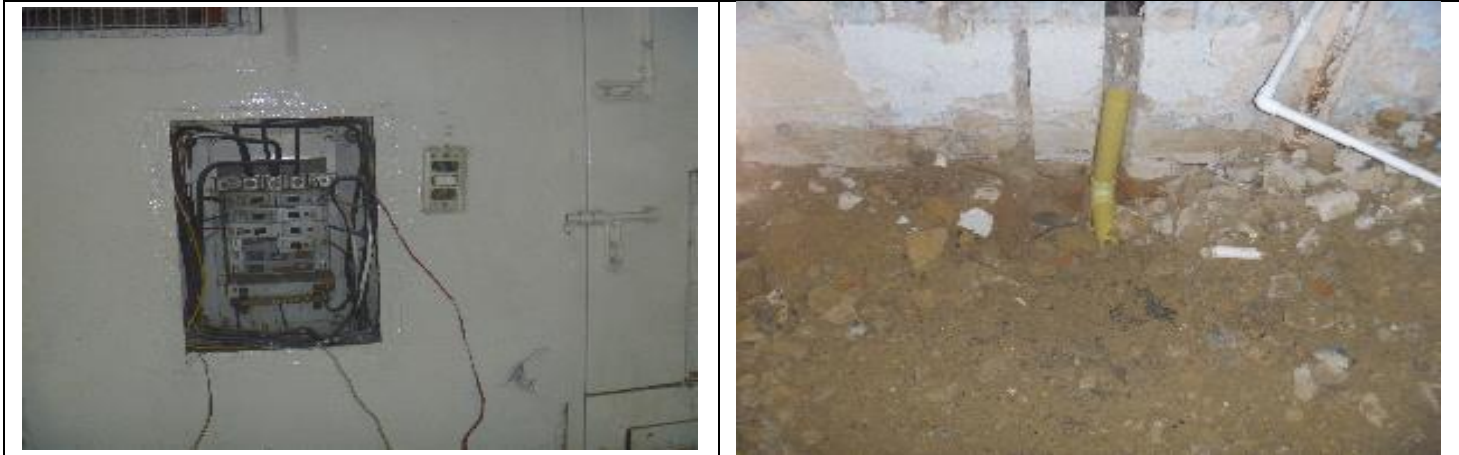
Instalación de redes sanitarias y sistemas eléctricos
