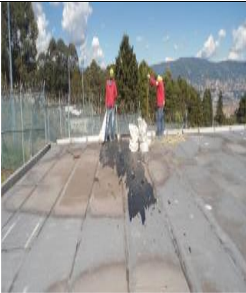
Retiro de impermeabilización en cubiertas.
