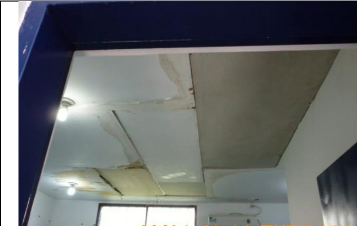
Mantenimiento y reparación cielo raso de consultorios de sanidad.
