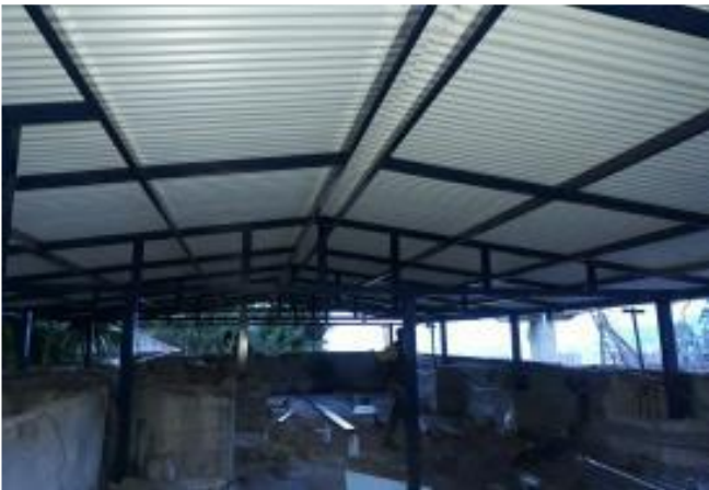
Estructura y cubierta en área de dirección.
