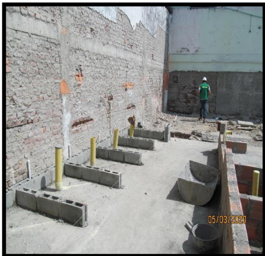
Construcción baterías sanitarias – Patio 6
