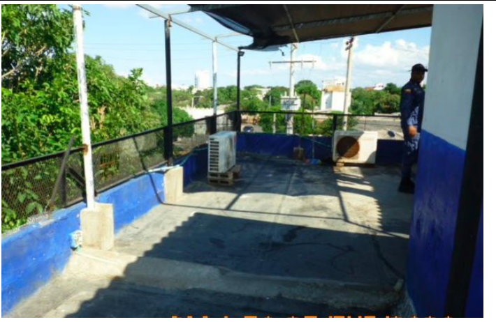
Mantenimiento y adecuación de cerramiento terraza.
