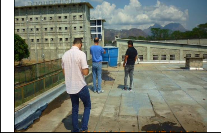
Reparación y optimización de impermeabilización cubierta de sanidad.
