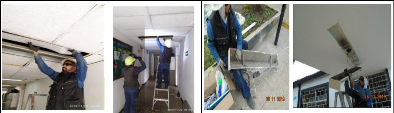
Mantenimiento luminarias en área administrativa
