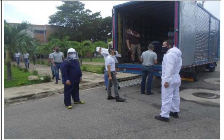
TRASIEGO DE MATERIALES DE OBRA DESDE LA ENTRADA DEL
