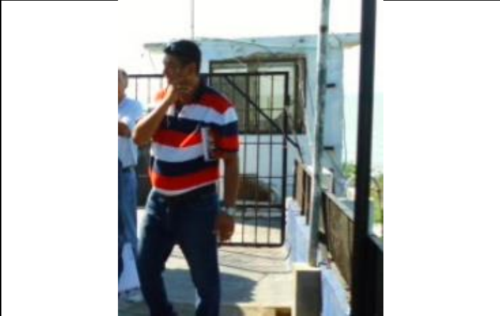
Mantenimiento y reparación impermeabilización cubierta de 2 garitas.
