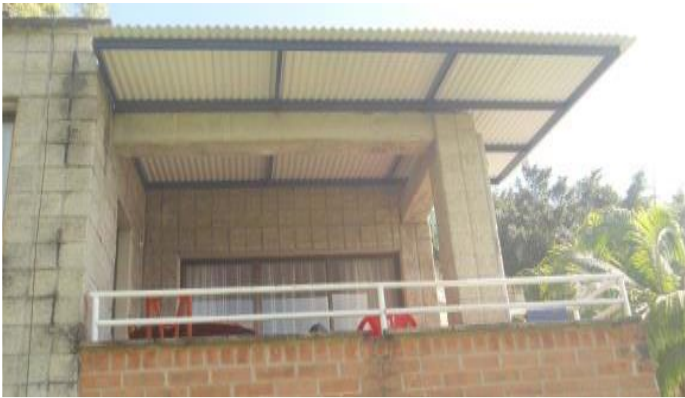
Cubierta en balcón, frente casa fiscal, segundo nivel.
