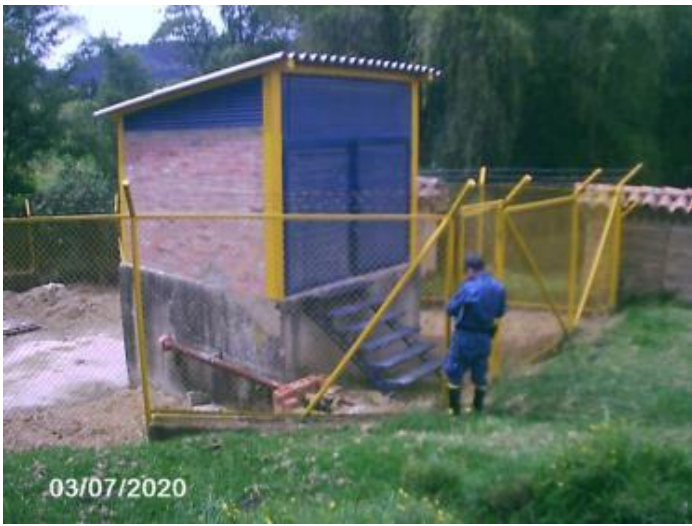
Nuevo cuarto para planta eléctrica bocatoma de agua rio Tuta
