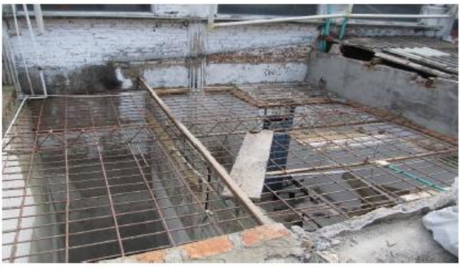
Desmante de estructura y cubierta para realce de la misma para cubrimiento zona primer piso.
