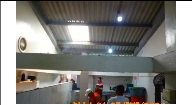
Mantenimiento y adecuación del área de rancho.
