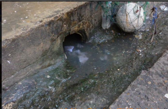
Mantenimiento y reparación red hidrosanitaria pabellón N°2.
