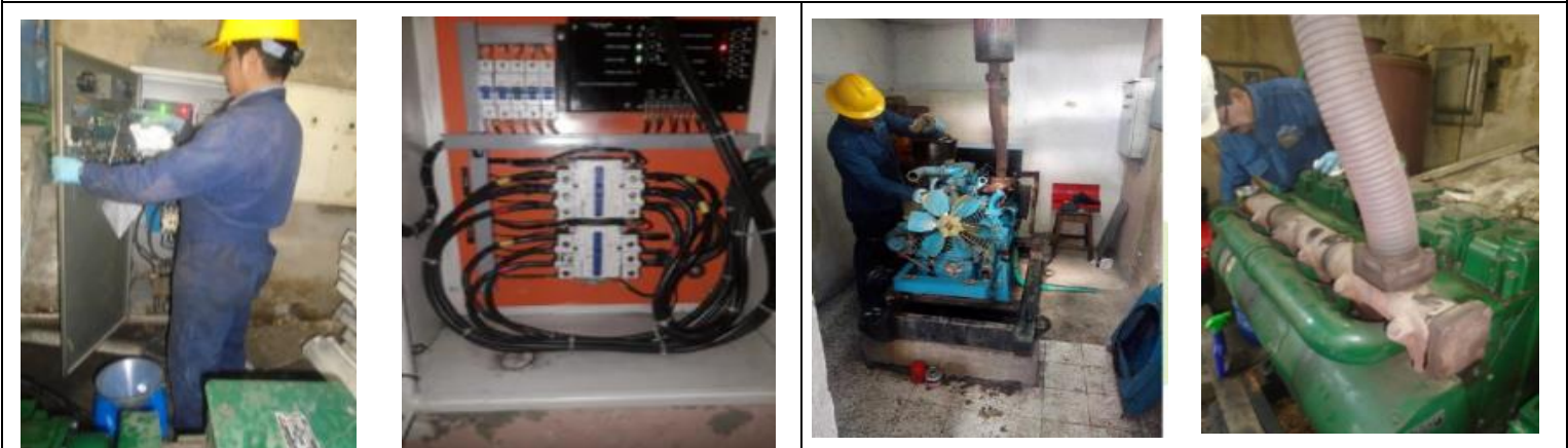
Mantenimiento de transferencia automática Mantenimiento planta eléctrica
