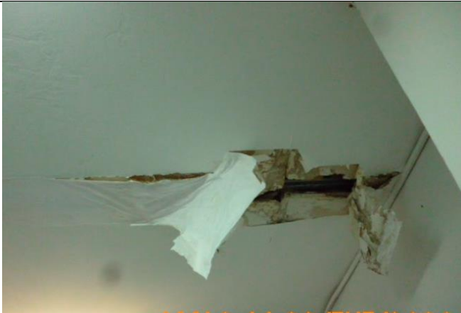
Mantenimiento y reparación cielo raso de consultorios de sanidad.
