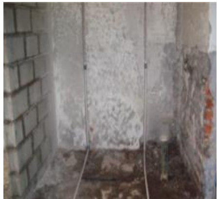
Demoliciones en piso, Muro en bloque de concreto- Instalaciones hidráulicas- Aplicación de estuco acrílico
