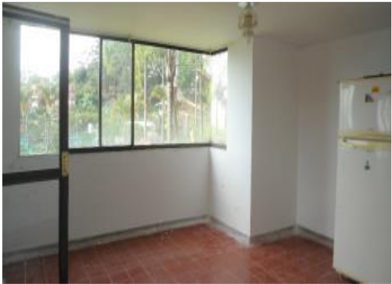
Pintura general casa fiscal.
