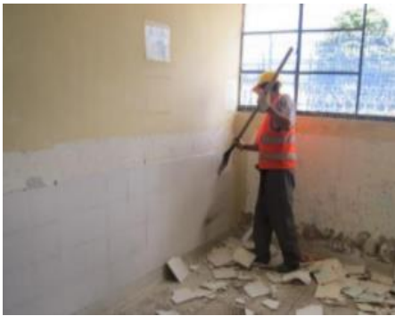
Demolición de enchape de piso- Demolición de enchape de pared- Retiro de material producto de las demoliciones
