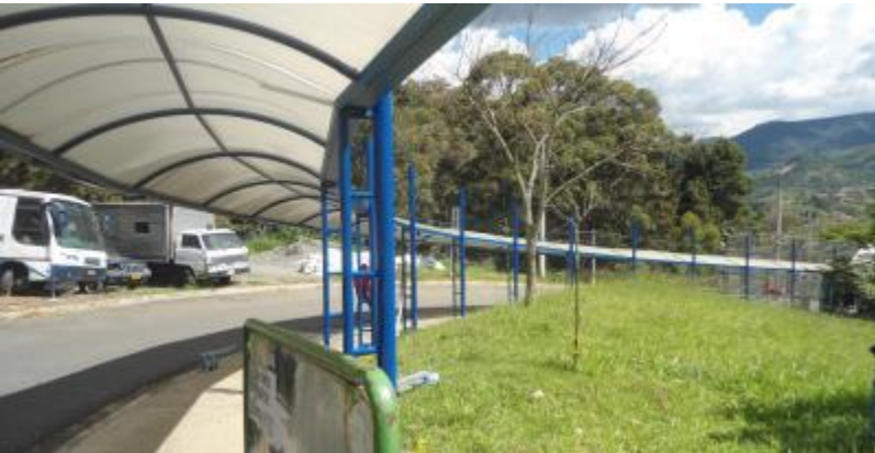
Mantenimiento de estructura de cubiertas en senderos peatonales, incluye pintura, raspado y anticorrosivo.
