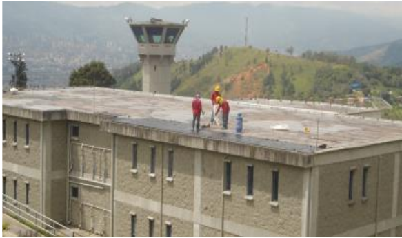
Retiro de impermeabilización en cubierta de mínimas.
