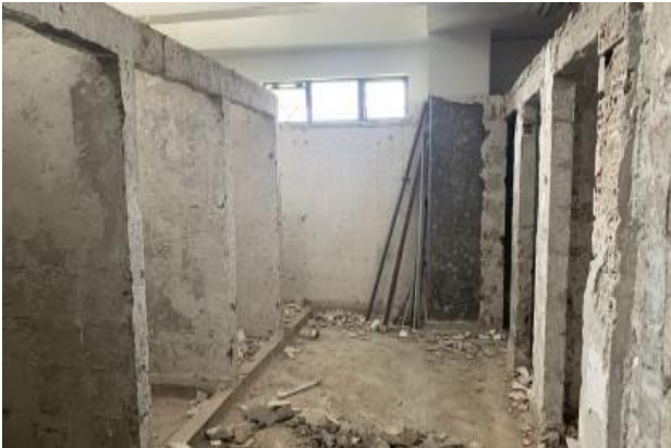
Demolición de enchapes y pañetes, en baterías sanitarias, frente alojamientos.
