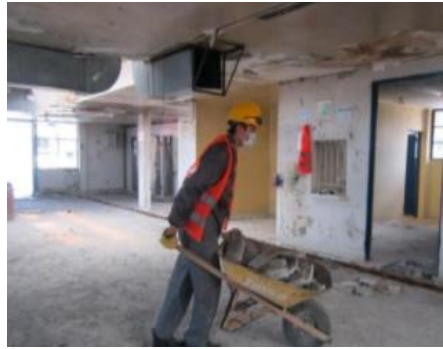
Demolición de enchape de piso- Demolición de enchape de pared- Retiro de material producto de las demoliciones
