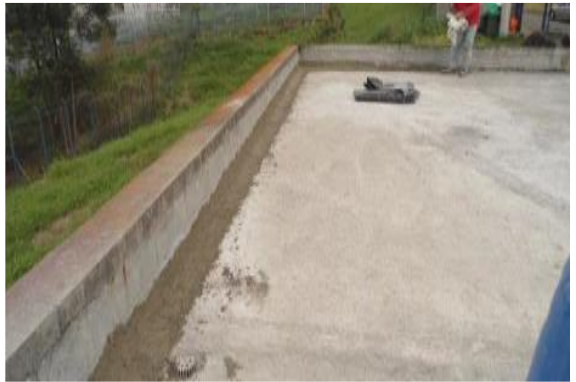
Alistado en cubierta para impermeabilización, frente visitas y snacks.- Media caña en cubierta de visitas y snacks, para impermeabilización.
