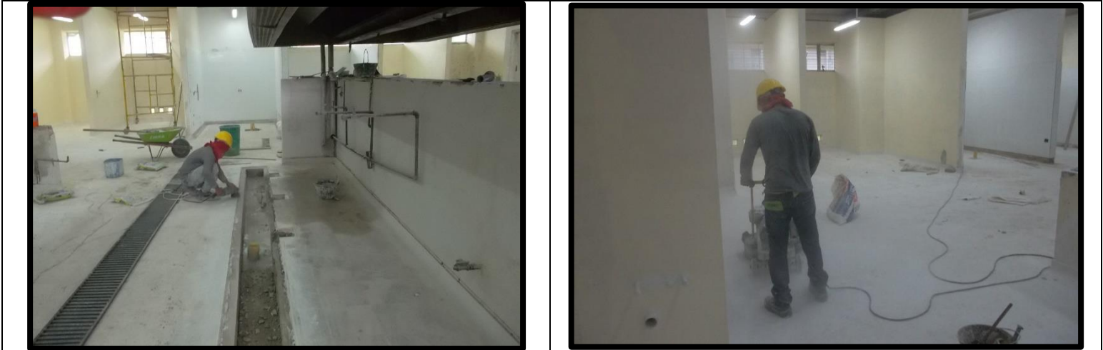
Actividades de adecuación y mantenimiento de Rancho
