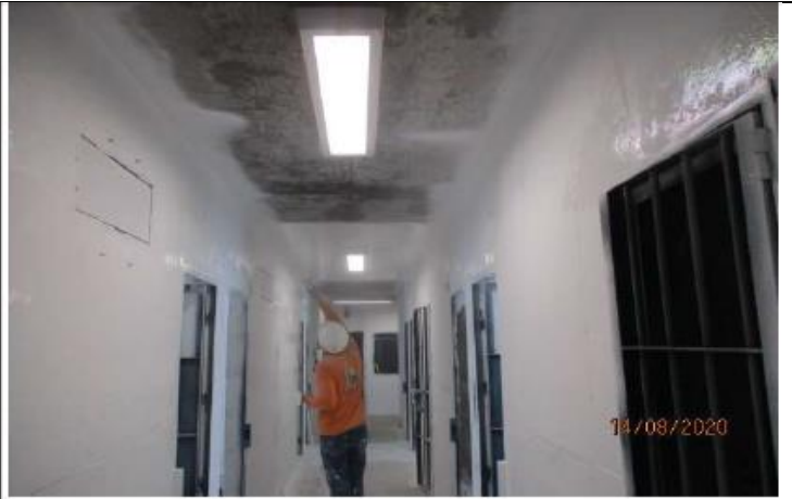
Suministro e instalacion de luminarias externas celdas UTE.
