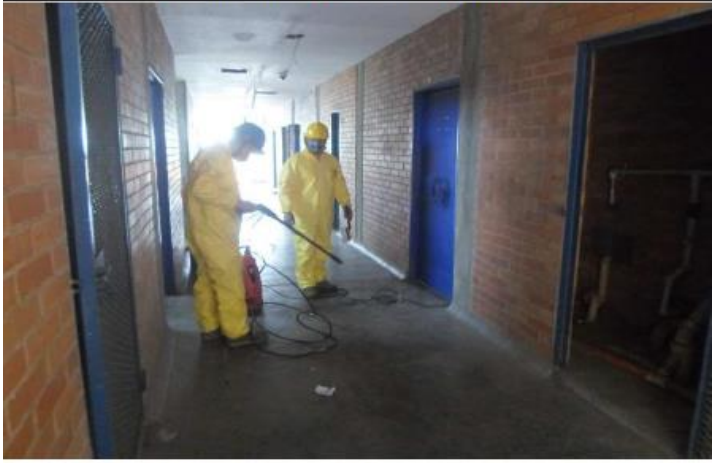
LIMPIEZA DE MUROS EXISTENTES CON HIDROLAVADORA
