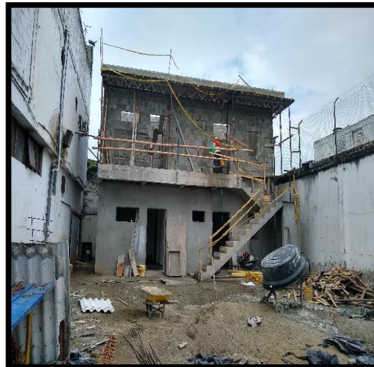
Construcción alojamiento de guardia
