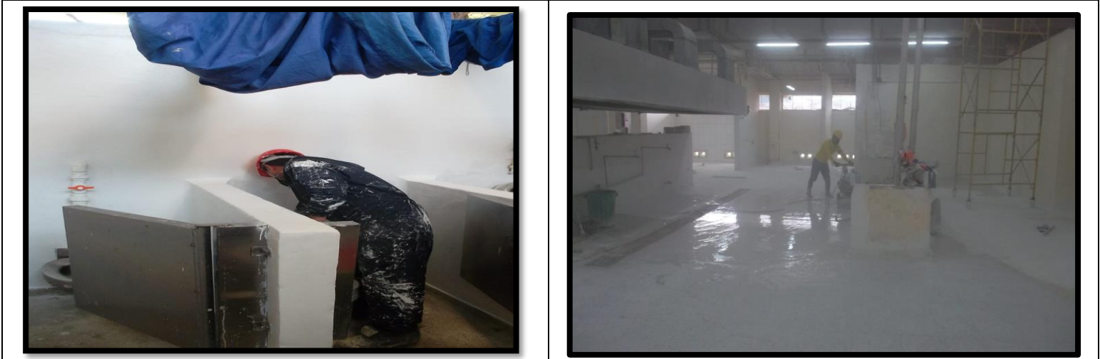
Actividades de adecuación y mantenimiento de Rancho
