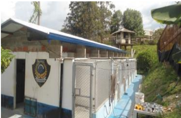
Estructura para cubierta, en área de cubierta en caniles.
