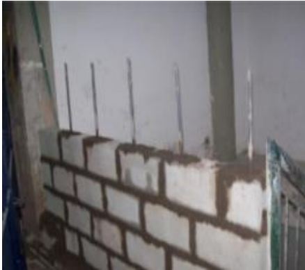
Demoliciones en piso, Muro en bloque de concreto- Instalaciones hidráulicas- Aplicación de estuco acrílico
