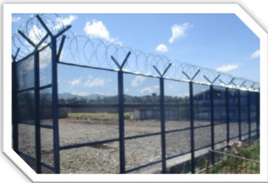
Cerramiento malla y área demolida
