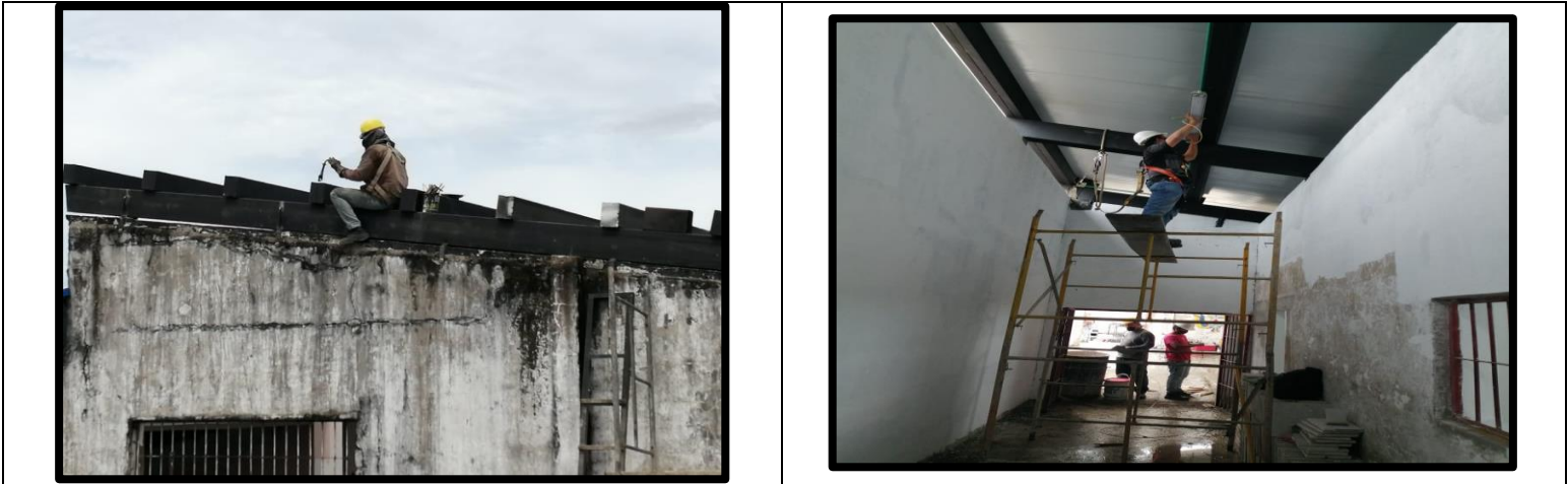
Actividades de mantenimiento de cubierta e instalación de luminarias Registro fotográfico – EP FLORENCIA (LAS HELICONIAS)
