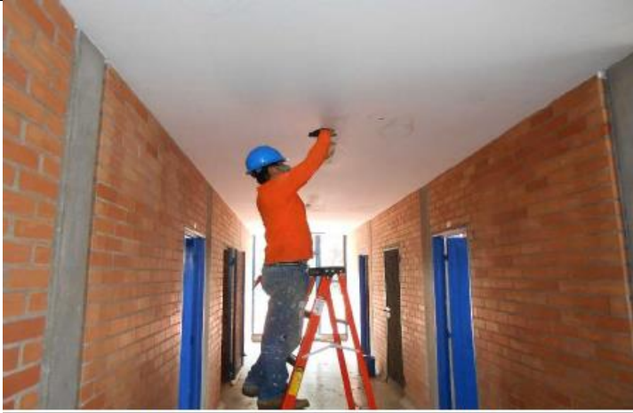
MEJORAMIENTO DE CABLEADO LAMPARAS
