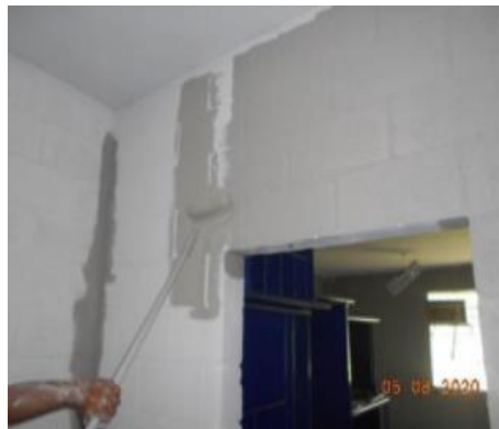
Pintura vinilo primera mano zona extramuros- Celdas UTE para hidro lavado, desinfección y pintura.-Raspado de paredes UTE- Pintura capa final zona extramuros.
