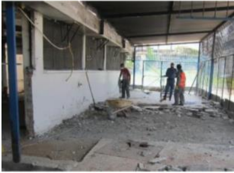
Demolición de enchape de piso- Demolición de enchape de pared- Retiro de material producto de las demoliciones
