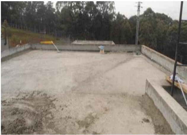
Alistado en cubierta para impermeabilización, frente visitas y snacks.- Media caña en cubierta de visitas y snacks, para impermeabilización.
