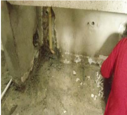
Instalación de tubería hidráulica en baterías sanitarias en alojamientos.
