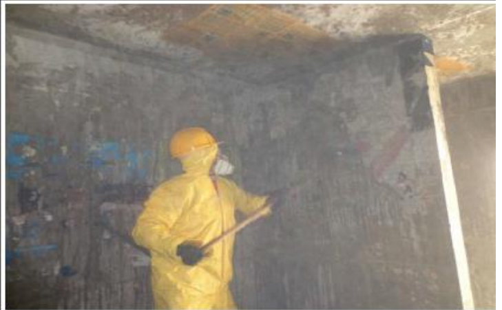
Lavada de celdas zona de UTE (unidad de tratamiento especial).
