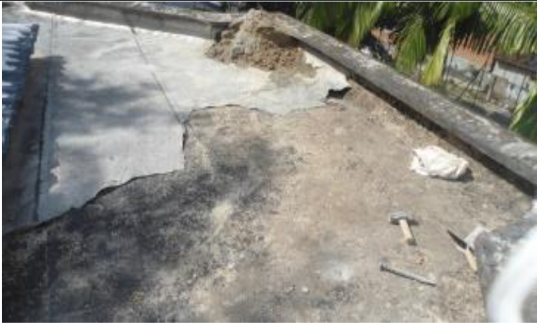
Retiro de losa existente en cubierta casa fiscal.
