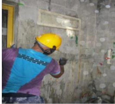
Pintura vinilo primera mano zona extramuros- Celdas UTE para hidro lavado, desinfección y pintura.-Raspado de paredes UTE- Pintura capa final zona extramuros.
