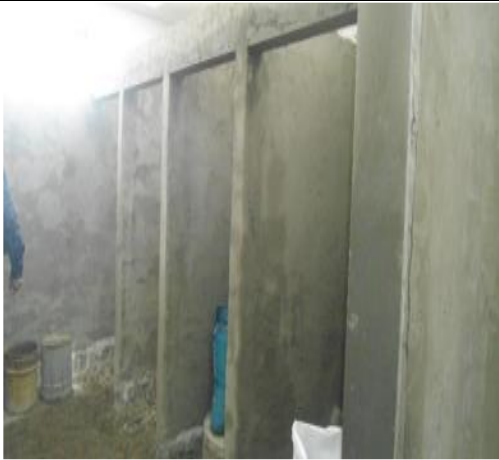
Revoque en muros, en frente de baterías sanitarias de alojamiento.
