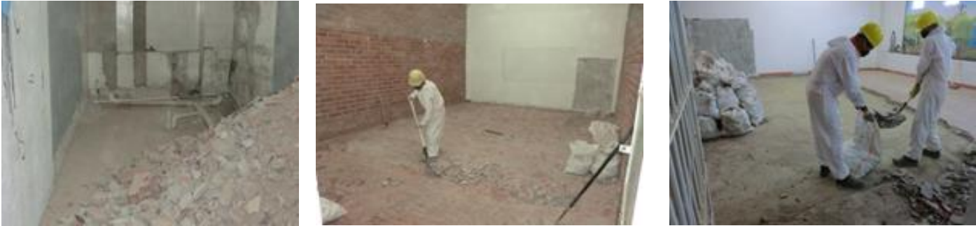
Demolición de pisos y retiro en baños de hall zona de aislamiento-Demolición de pisos y retiro de pintura en aula educativa 1 para zona de aislamiento-Demolición de pisos y retiro de pintura en aula educativa 2 para zona de aislamiento
