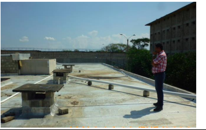
Reparación y optimización de impermeabilización cubierta de sanidad.
