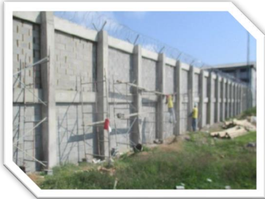
cerramiento definitivo en mampostería
