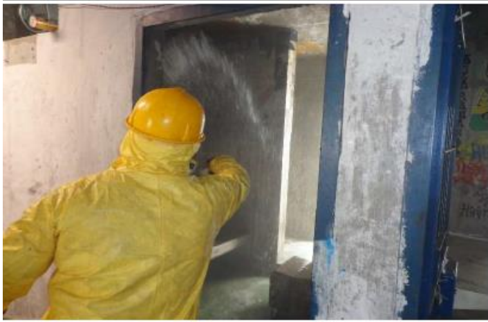
Lavada de celdas zona de UTE (unidad de tratamiento especial).
