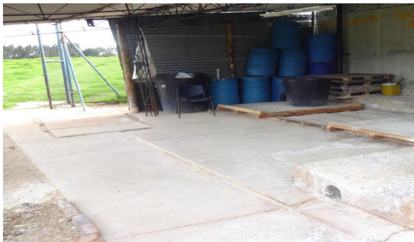
Foto No. 01 – Bodega de químicos
