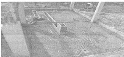
Instalación de malla electrosoldada de refuerzo para placa de piso de subestación
