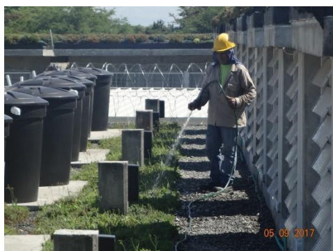
Puntos de riego en cubiertas
