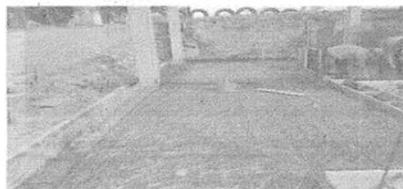
Instalación de malla electrosoldada de refuerzo para placa de piso de subestación
