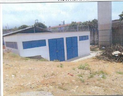
TERMINACION DE CUARTO DE SUBESTACION
