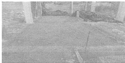
Detalle de relleno manual compactado de base de piso subestación
