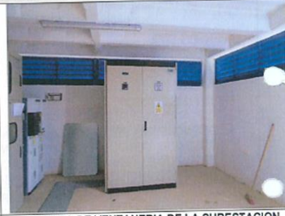
ACABADO DE VENTANERIA DE LA SUBESTACION
