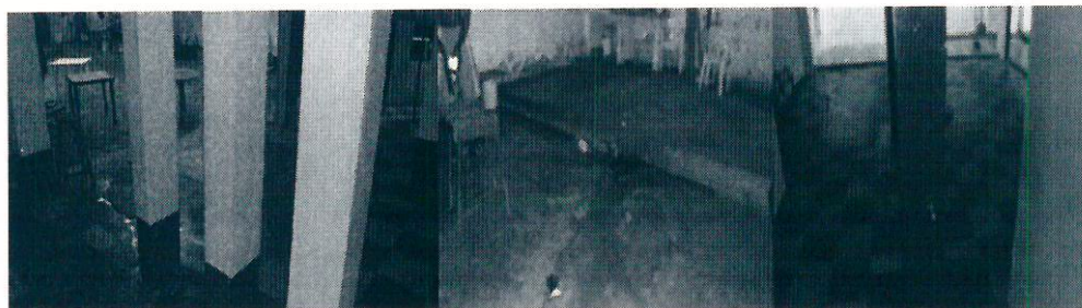
Nivelación de patios
