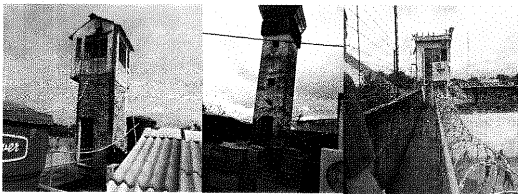
Garitas y acceso a garitas 1,2,3
